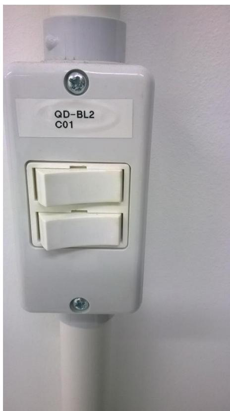
Figura 2 - exemplo: aplicação de interruptores no condutele
