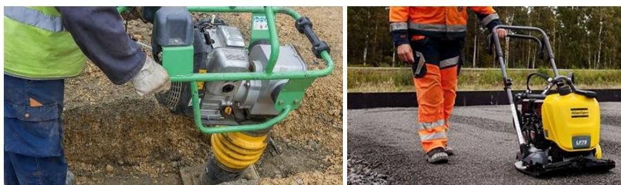
**Figura 1 – Apiloamento e nivelamento com compactador de solo (esq) e placa vibratória (dir)**
