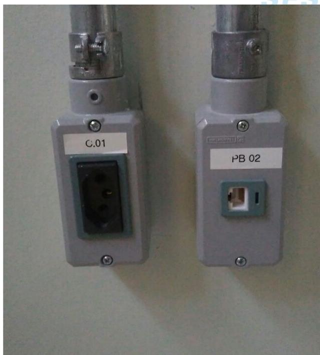
Figura 3 - aplicação de tomada elétrica e de telecomunicações, respectivamente, no condutele
